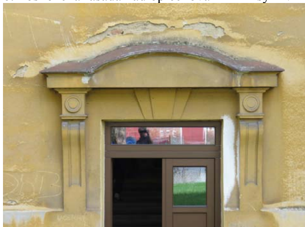
6. Poškozená fasáda nad oplechováním římsy – vzlínající vlhkost
