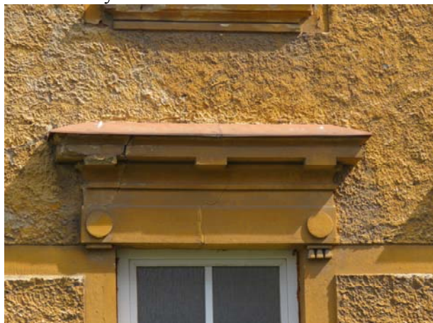
11. Zkorodované, poškozené klempířské prvky
