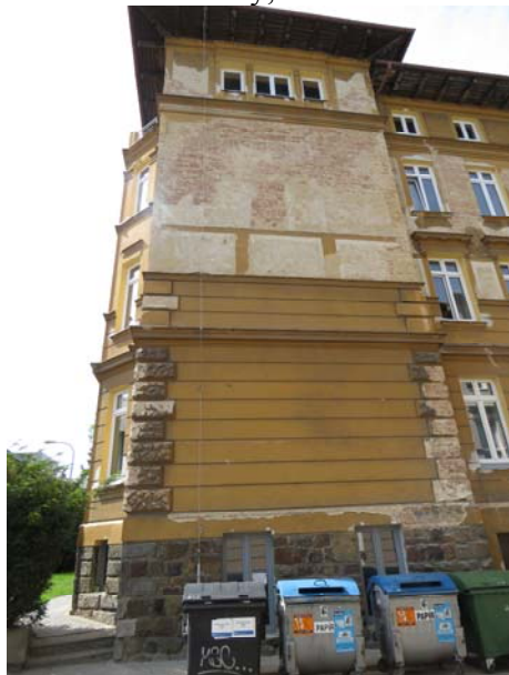
5. Odstraněné štuky, bosáže a omítka ze severovýchodní fasády, obnažené cihelné zdivo
