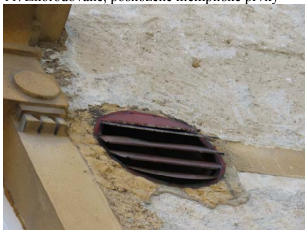
12. Koroze zámečnických prvků a neodstraněné zbytky zámečnických prvků
