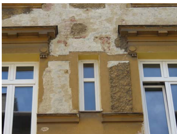
6. Poškozená fasáda nad oplechováním římsy – vzlínající vlhkost
