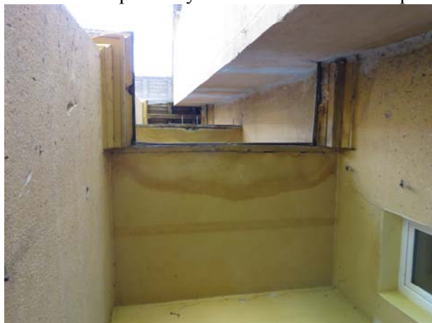
8. Poškozený fasáda od zatékání do římsy, poškozené římsy
