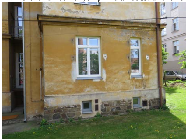
12. Koroze zámečnických prvků a neodstraněné zbytky zámečnických prvků
